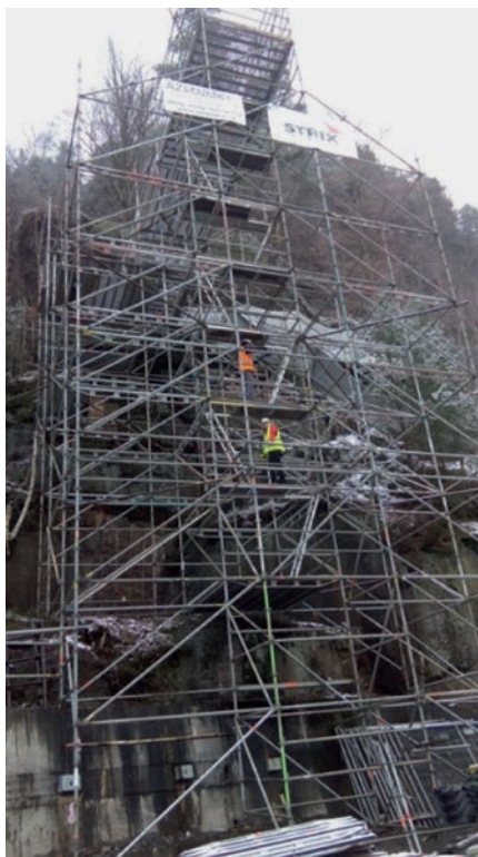
Obr. 4.05 Lešení zbudované k instalování zábran proti opadávání skal v Hřensku, 11. 5. 2015 [ http://usti.idnes.cz/site-proti-padu-skal-v-hrensku-dea-usti-zpravy.aspx?c=A150210_162129_usti-zpravy_alh ]
