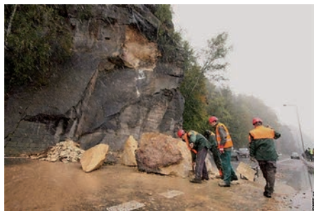
Obr. 4.02 Pád skalního bloku na silnici mezi hraničním přechodem s Německem a Hřenskem, 15. 10. 2009 [ http://zpravy.idnes.cz/ve-hrensku-spadla-na-silnici-do-nemecka-skala-nikdo-se-nezranil-pbl-/krimi.aspx?c=A091015_120602_krimi_jba ]
