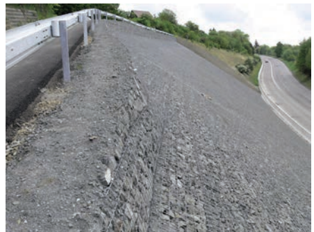
Obr. 5.05 Ilustrační foto: Sanace svahu [Časopis Stavebnictví 2014, č. 4, http://www.casopisstavebnictvi.cz ]
