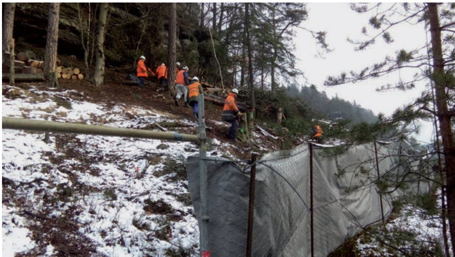
Obr. 4.06 Instalace sítí v horních částech skalního bloku nad silnicí v Hřensku, 11. 5. 2015 [ http://usti.idnes.cz/site-proti-padu-skal-v-hrensku-dea-/usti-zpravayasp?c=A150210_162129_usti-zpravy_alh ]
