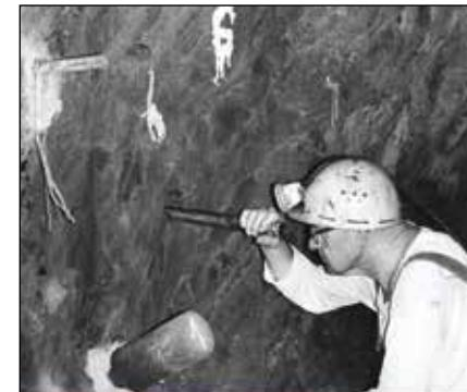
Alois Přikryl při měření porušenosti horniny pomocí introskopu, Uhelné doly Příbram, bez datace, foto Renáta Louvarová (Záběhlická)
