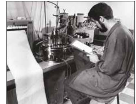
Petr Glogar při měření teplotní vodivosti vzorků hornin z příbramského uranového ložiska. Měření této veličiny bylo zásadní s ohledem na tepelnou výměnu (ohřev) důlního ovzduší na hlubokých patrech dolů, kde teplota horniny přesahovala 35°C, a bylo proto nezbytné důlní ovzduší nákladně chladit. Přístroj na měření teplotní vodivosti P. Glogar vyvinul a zkonstruoval.
