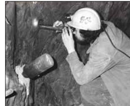
Měření porušenosti horniny pomocí introskopu, Uhelné doly Příbram, na snímku J. Přidal, zaměstnanec Uhelných dolů Příbram, bez datace, foto Renáta Louvarová (Záběhlická)
