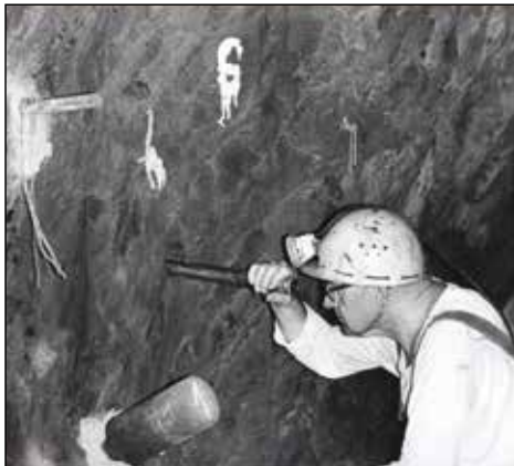
Alois Příklad measuring rock deformation with an introscope. Příbram Coal Mines, undated. Photo by Renáta Louvarová (Záběhlická). IRSM, collection of photographs.
