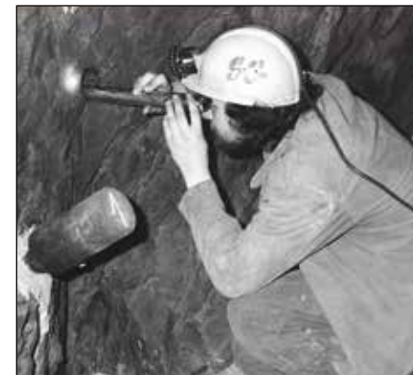
Measurement of rock deformation using an introscope. Příbram Coal Mines, J. Přidal, employee of the Příbram Coal Mines, undated. Photo by Renáta Louvarová (Záběhlická).
